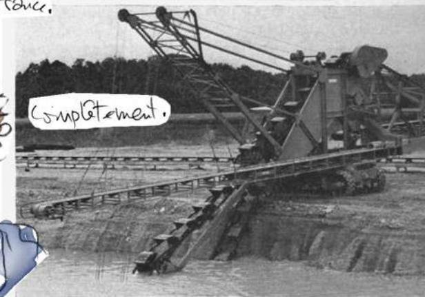
Fig. 3. — Cet excavateur à godet sur chenilles charge directement sur un convoyeur à bande après criblage et rejet dans l'excavation des éléments trop gros (phot. X).
